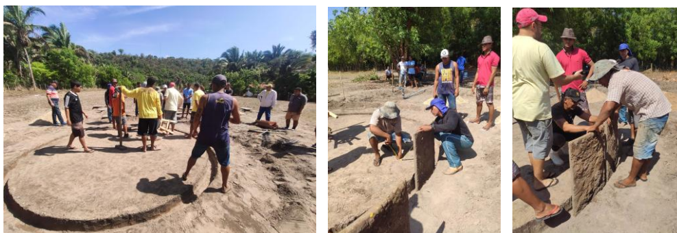
Figura 2: Ajuste no perímetro e encaixe das placas
