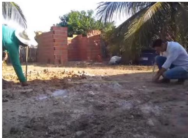
Figura 1: Demonstração da marcação do perímetro do reservatório.
